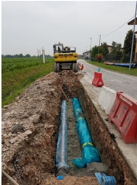
Lavori di collegamento area artigianale di Albignasego alla rete fognaria confluyente all'impianto di depurazione – prog. n. 867
