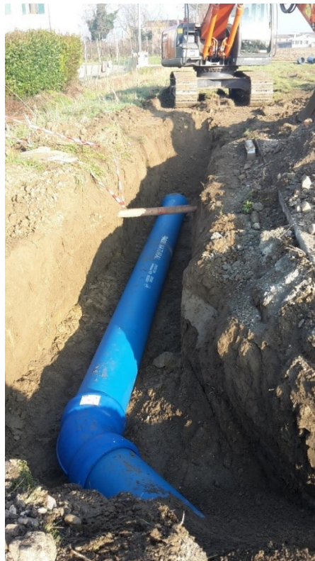
Lavori di sostituzione della condotta idrica ammalorata in Comune di Anguillara Veneta - tratto da SP 92 ex Tabacchificio Anguillara alla Centrale di sollevamento di Conselve I Stralcio – prog. n. 801A
