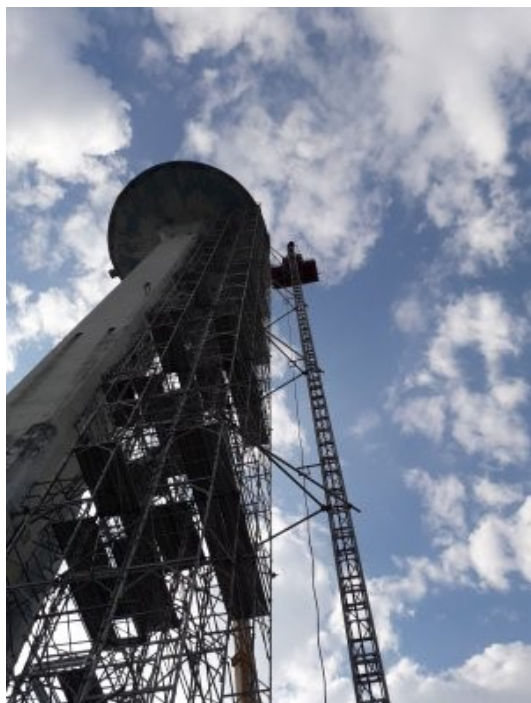
Prog. n. 81 – Interventi di sistemazione strutturale del serbatoio pensile presso la centrale di potabilizzazione di Boara Polesine
