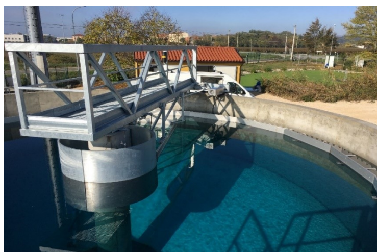
Lavori di adeguamento dell'impianto di depurazione di Alonte – prog. n. 223
